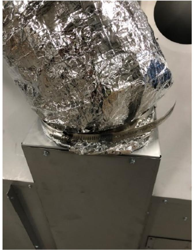
Figure 2.4, Installez le collier de serrage retenant l'isolant
