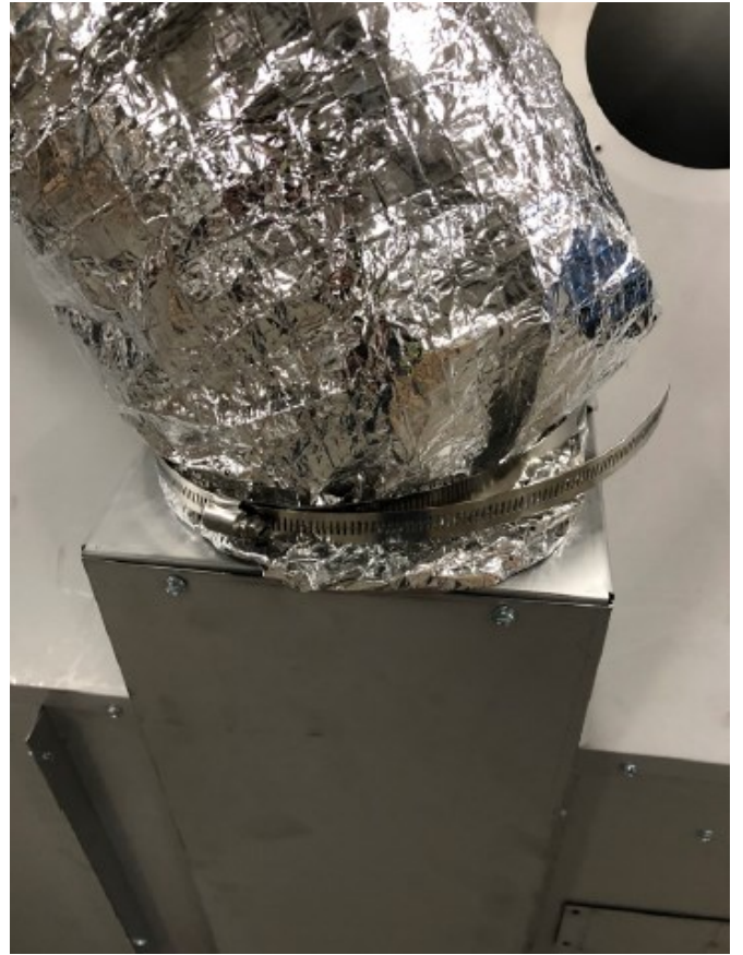
Figure 2.4, Installez le collier de serrage retenant l'isolant
