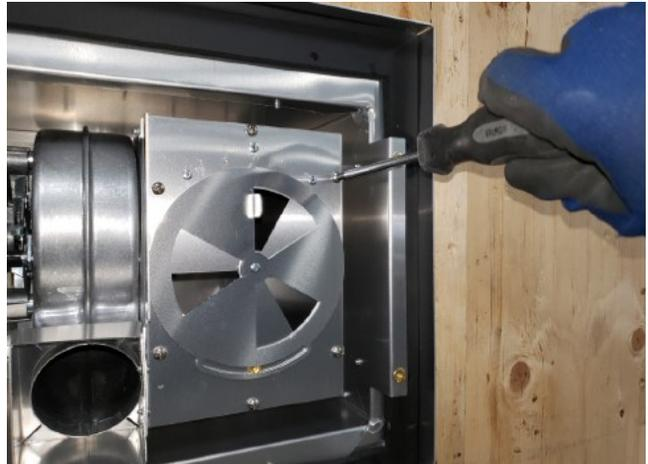
Figure 8.2 - Vis d'assemblage d'échappement
