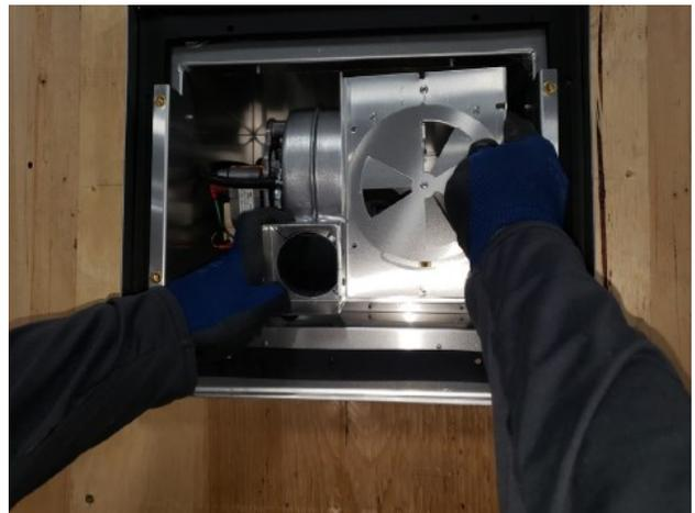
Figure 8.3 - Retrait de l'ensemble d'échappement
