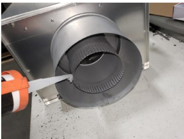
Figure 6.9 - Échappement intérieur en silicone sur l'ensemble d'évent motorisé
