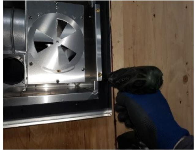
Figure 6.6 - Fixez l'évent électrique à l'extérieur
