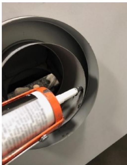
Figure 6.10 - Échappement intérieur en silicone sur foyer
