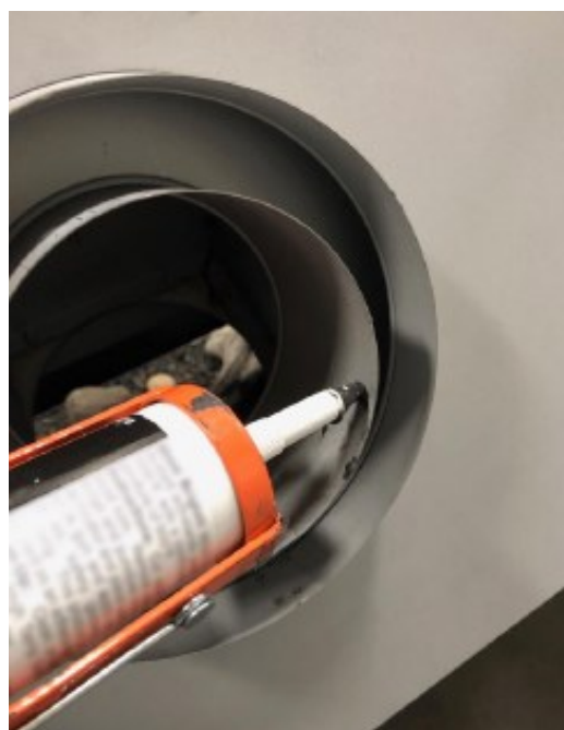
Figure 6.10 - Appliquer du silicone à la buse d'évacuation interne du foyer
