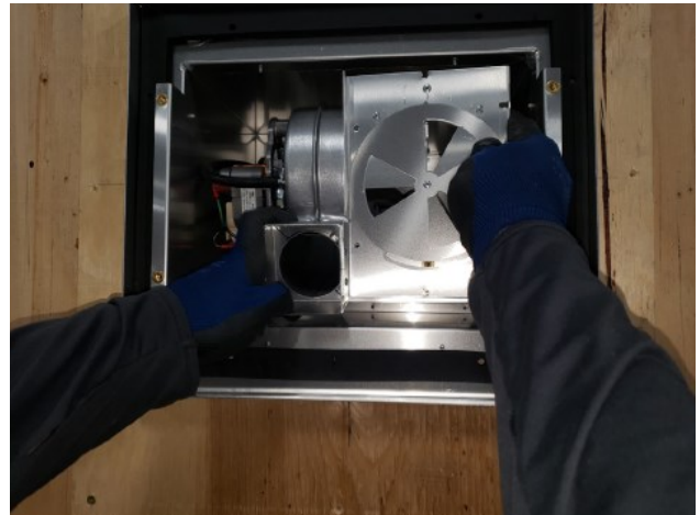
Figure 8.3 - Retrait de l'évacuateur
