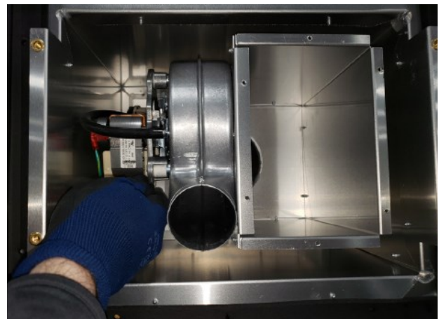
Figure 8.4 - Retirer ces 3 fils: porteur, neutre et terre
